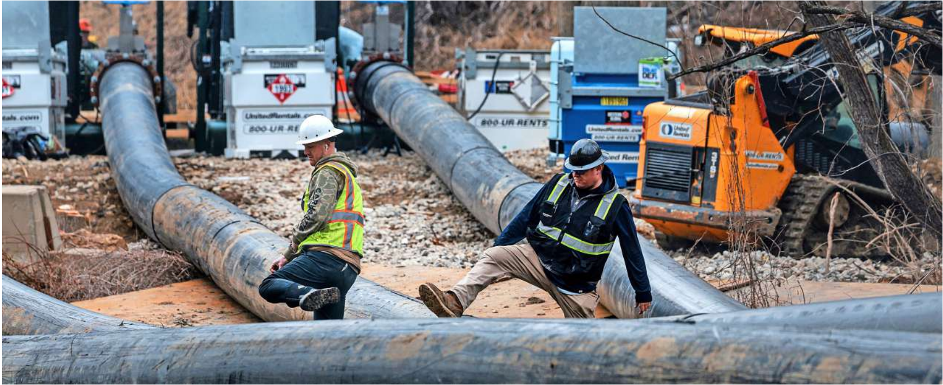
Großbaustelle am Potomac: Arbeiter montieren temporäre Abflussrohre, um die Reparatur einer kaputten Zentralleitung zu ermöglichen.
