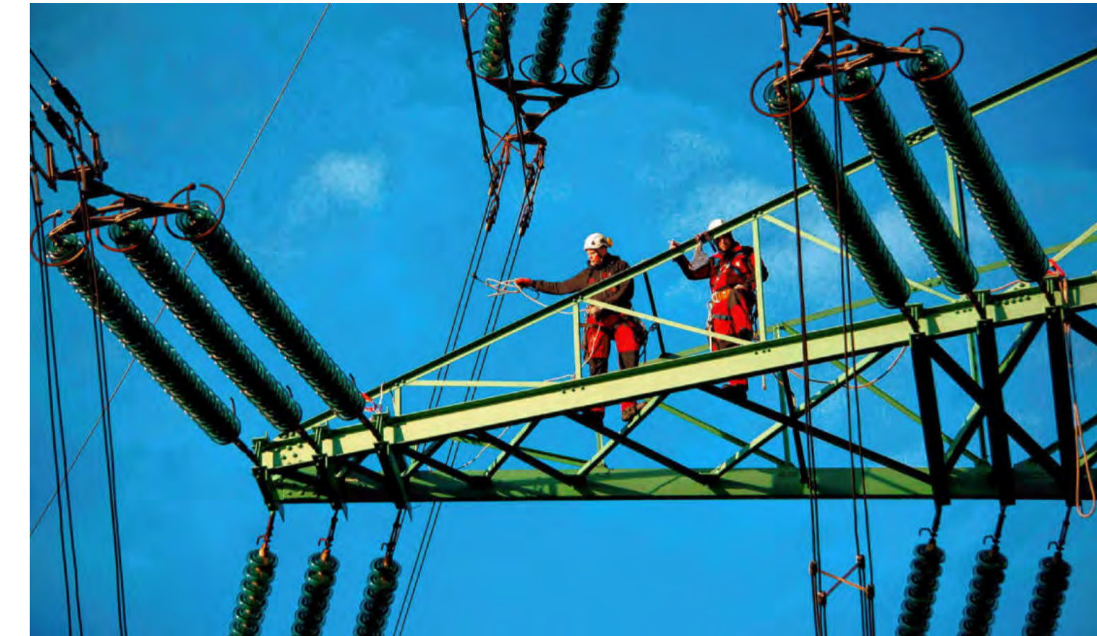
Industriekletterer in einem Strommast bei Wartungsarbeiten in Hamburg. Die Netze ächzen unter immer größeren Lasten. Denn der Strombedarf steigt durch die Energiewende rasant.
